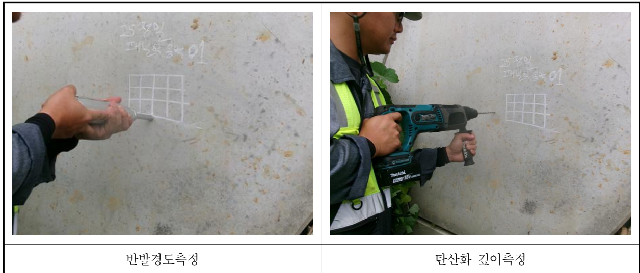
【사진 1.4.1】 재료시험 조사 전경
