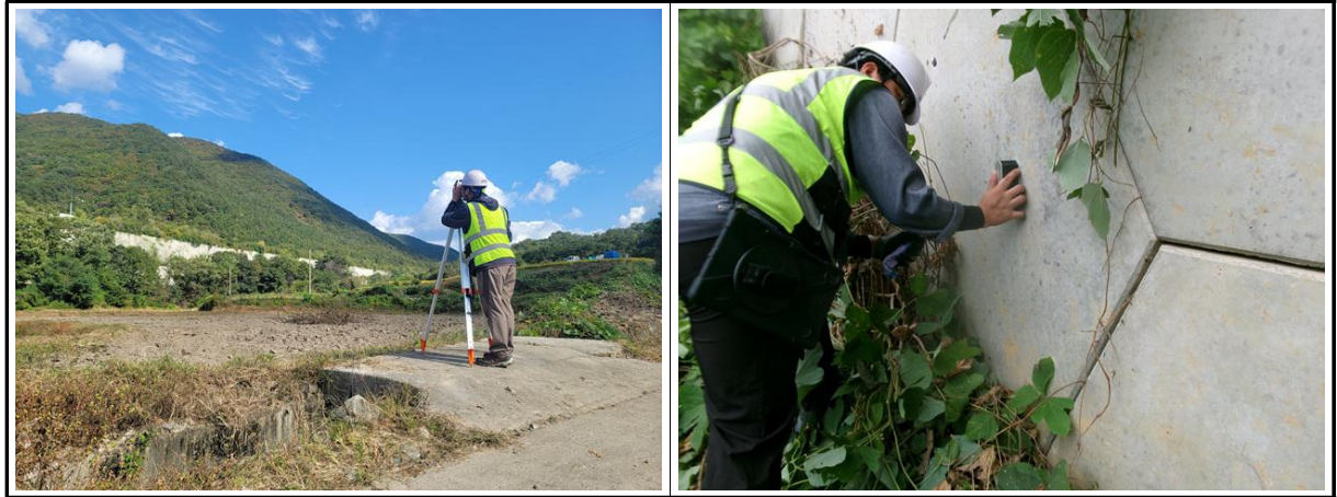
【사진 1.4.2】 측량작업 전경
