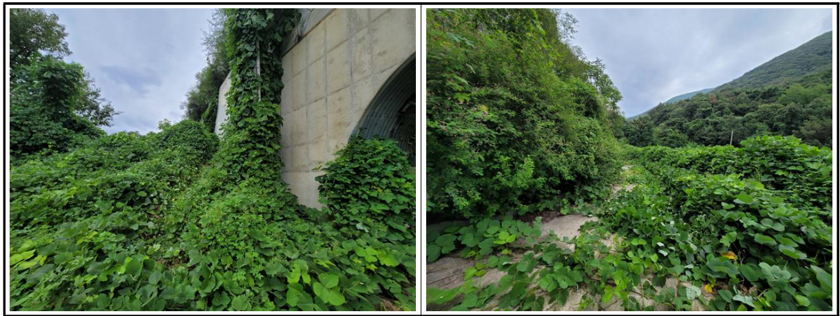
【사진 1.3.1】 지반, 기초부 전경
